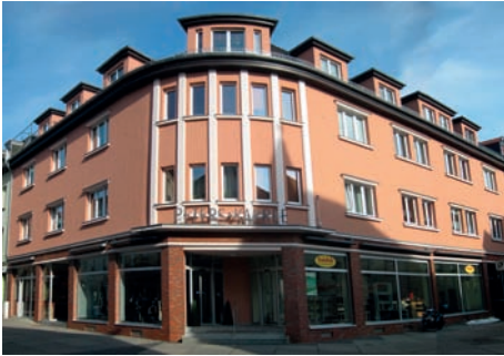
6100-0739 Wohn- und Geschäftshaus (12 WE) Umbau Seite 736
