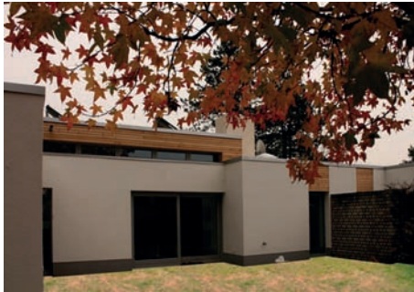
6100-0915 Einfamilienhaus - Effizienzhaus 70 Modernisierung
