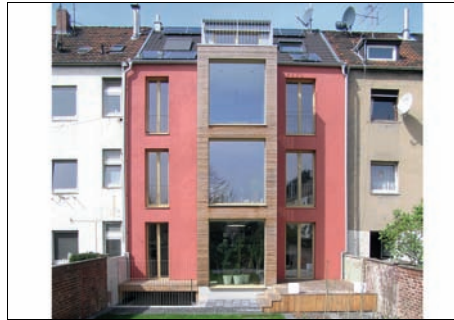
6100-0889 Mehrfamilienhaus (3 WE) - KfW 60 Modernisierung Seite 128
